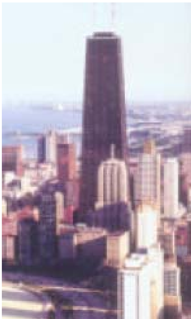
芝加哥John Hancock大厦， 钢斜撑周边桁架筒结构，1970年建成，100层，332m
