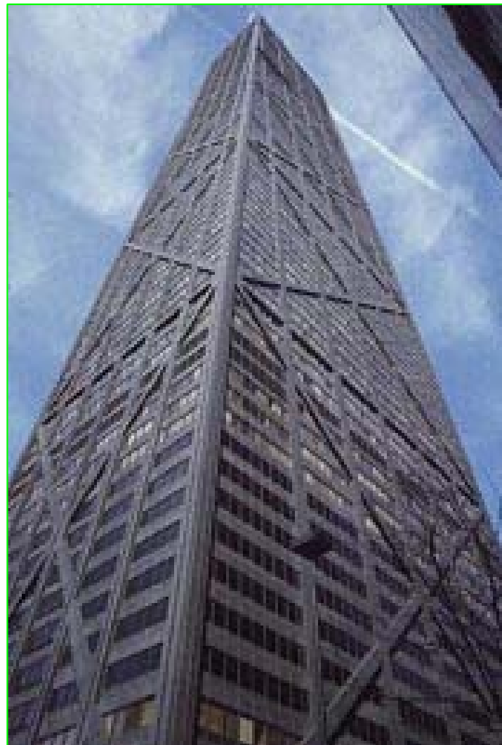
芝加哥John Hancock大厦， 钢斜撑周边桁架筒结构，1970年建成，100层，332m
