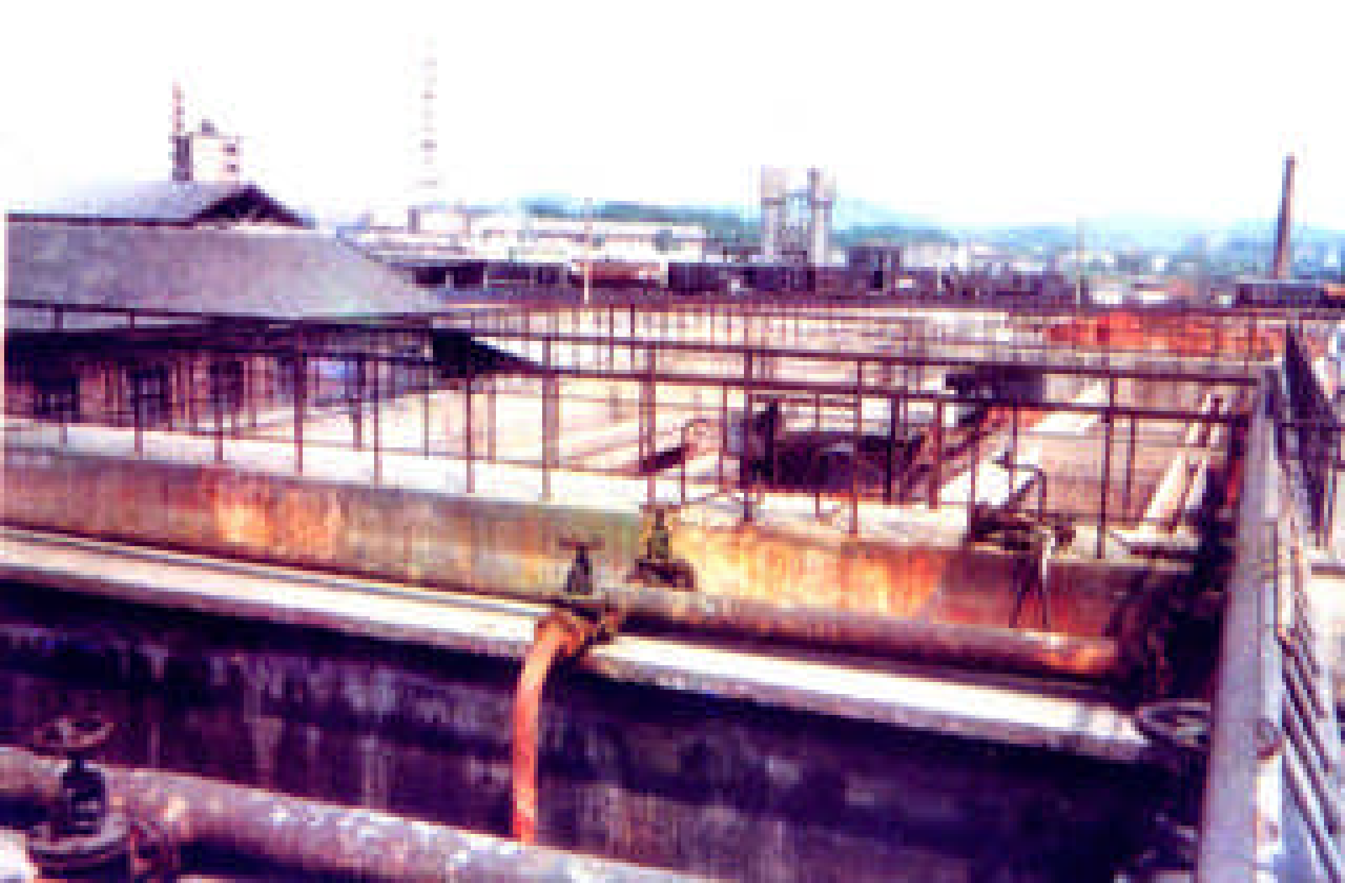
湖南长沙振升铝材有限公司大型 污水处理池采用玻璃钢衬里防腐蚀
