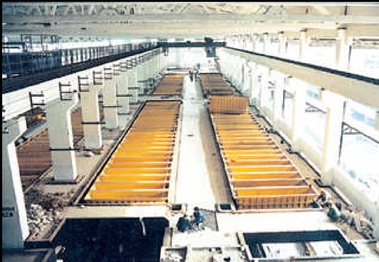
湖南株洲冶炼厂十万吨锌电解厂房地面主体 防腐及玻璃钢电解槽制作安装施工现场
