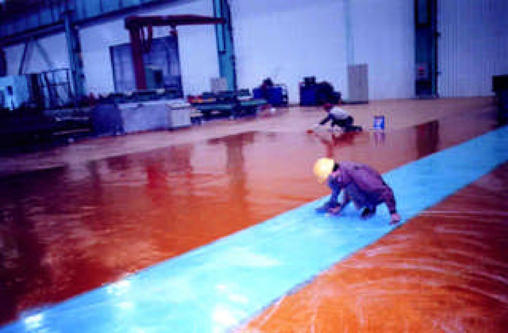
湖南湘潭钢铁集团公司宽厚板 轧机工程环氧地坪施工现场
