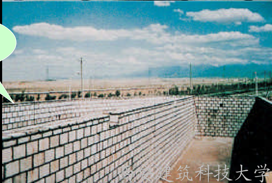
呋喃胶泥砌 砖板池槽
