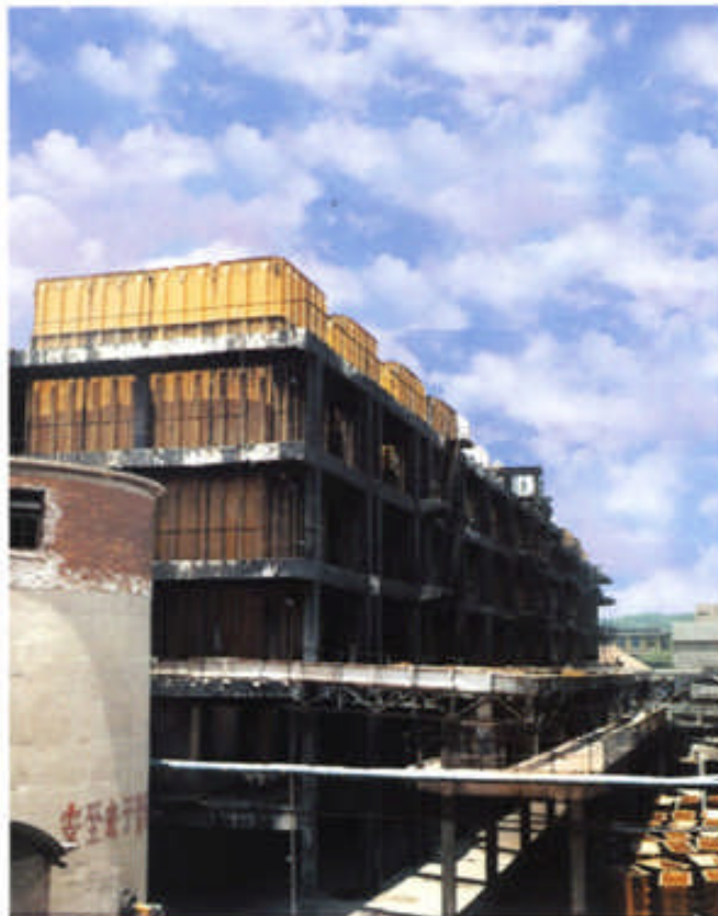
▲株洲冶炼厂500m 2 大型冷却塔及溜槽制作安装
